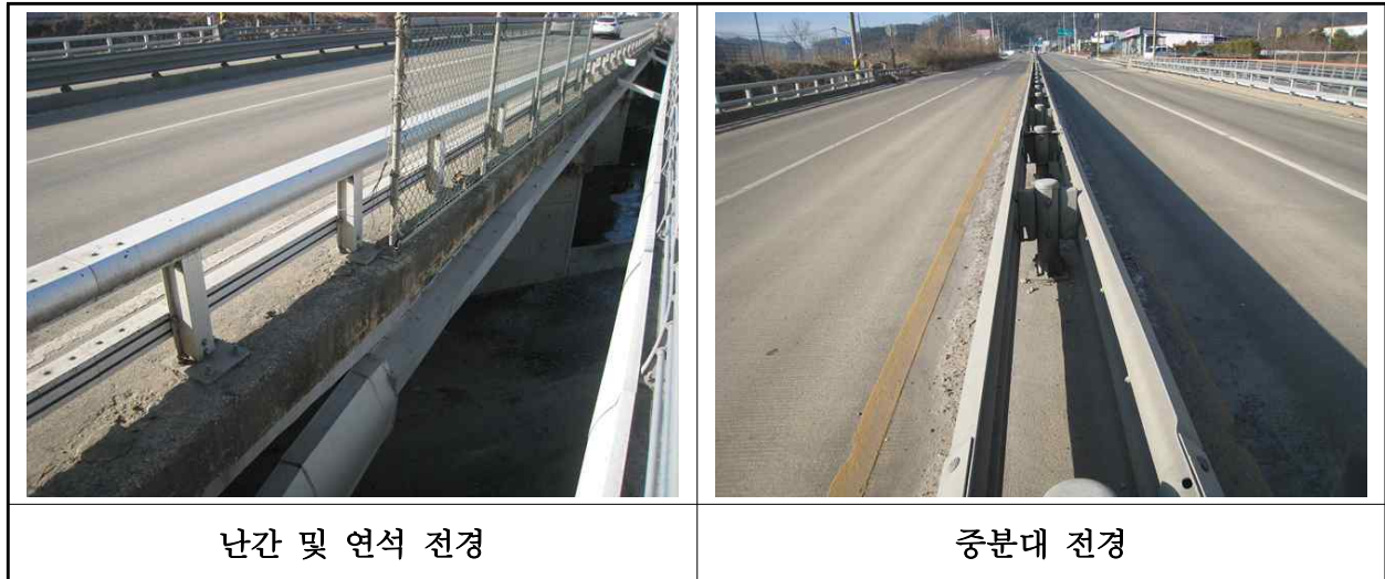
【사진 1.3.19】 난간 및 연석 전경
