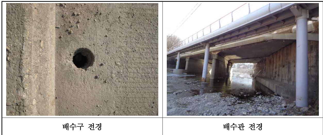
【사진 1.3.17】 배수시설 전경
