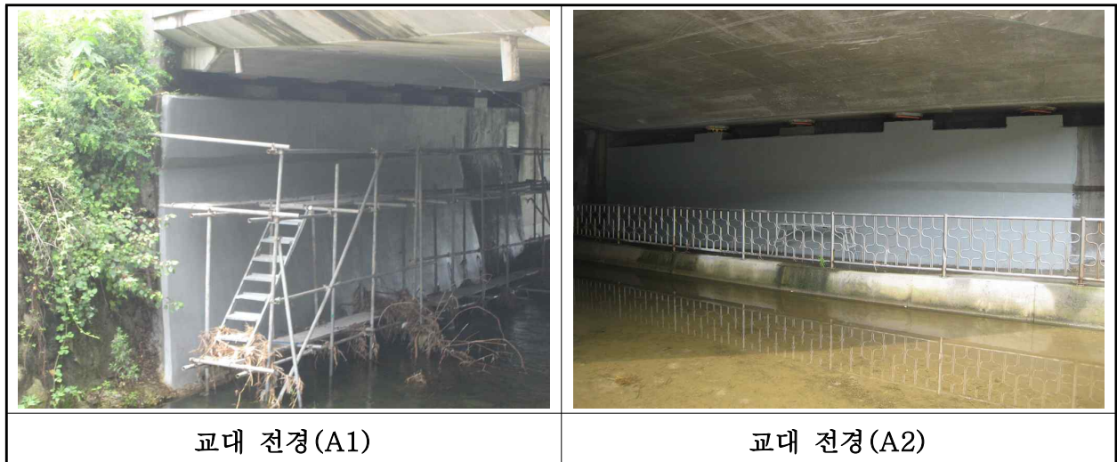
【사진 1.3.4】 교대 전경
