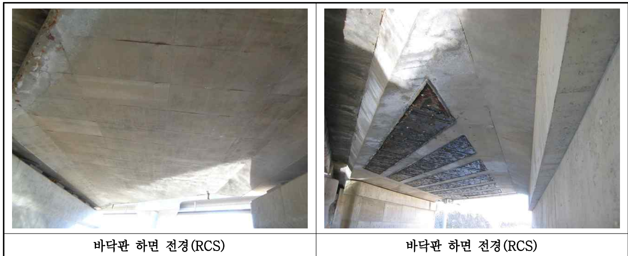
【사진 1.3.2】 바닥판 하면 전경
