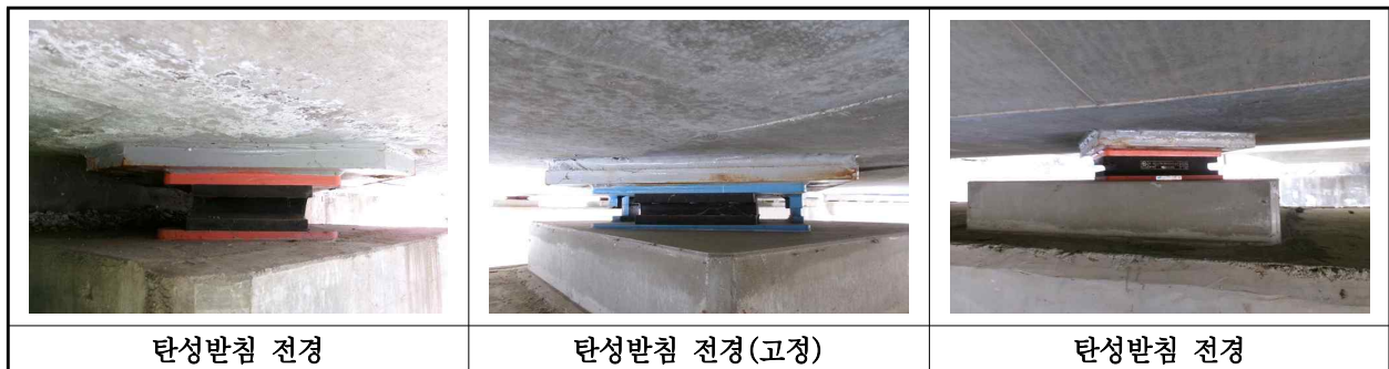
【사진 1.3.8】 교량받침 전경
