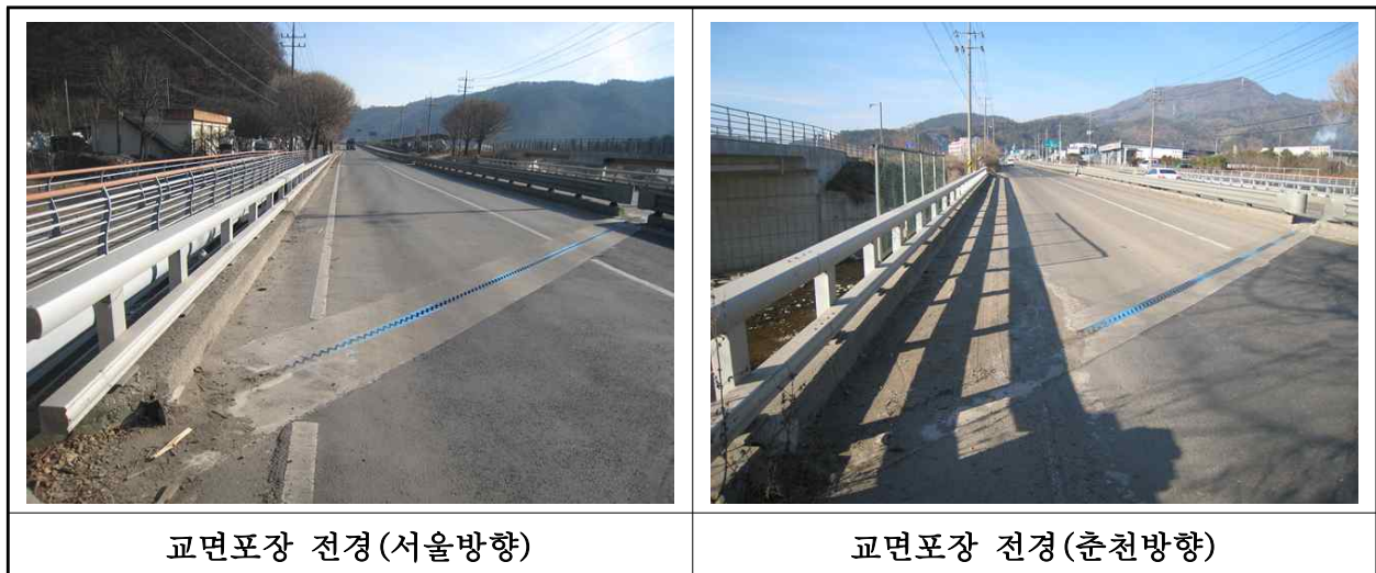
【사진 1.3.15】 교면포장 전경
