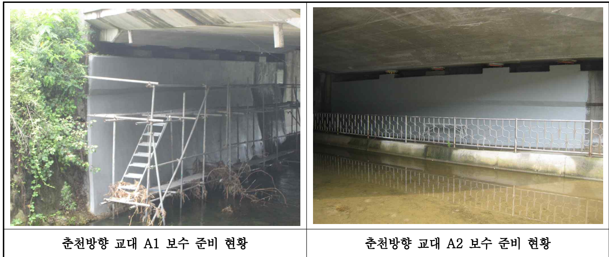
【사진 1.3.5】교대 손상현황(계속)
