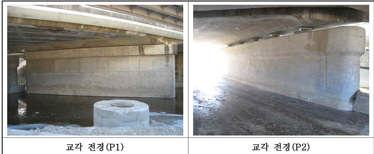
【사진 1.3.6】 교각 전경
